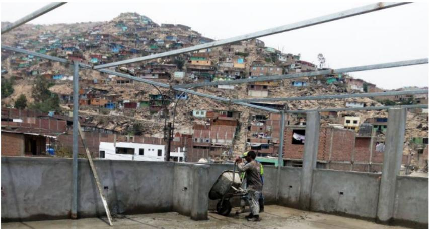
Dann ließen wir das dritte Stockwerk mit verzinktem Wellblech überdachen und den Boden betonieren.
